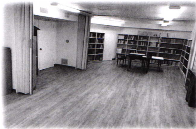
工事が完了した 別院地下教室の様子
